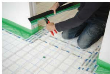
2. Tee lattialämmitysputkille reiät käyttämällä esimerkiksi loveamispihettä
