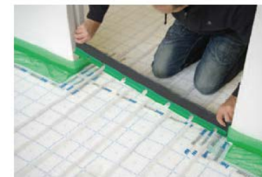
4. Aseta lista puhtaalle ja vakaalle alustalle niin, että putket asettuvat koloihin
