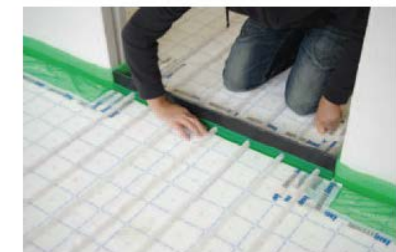
5. Paina liimapinta tiukasti lattiaa vasten. Listan sivut tiivistetään esimerkiksi tiivistysteipillä tai uretaanivaahdolla.
